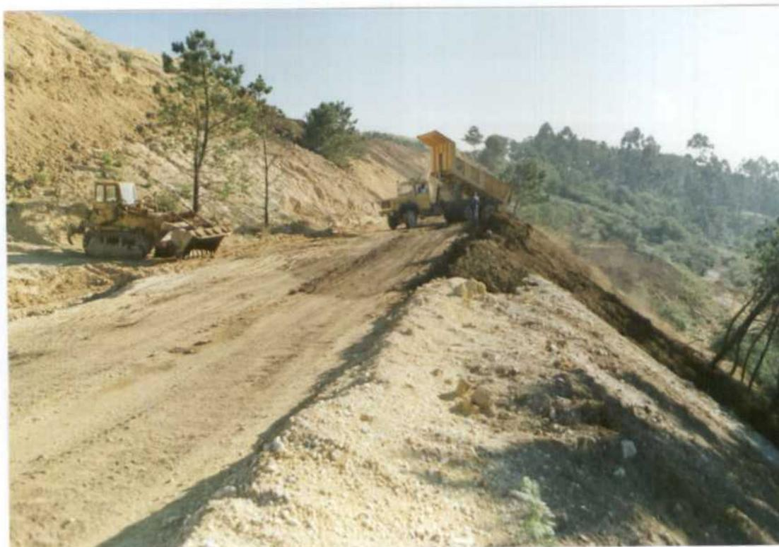
FOTO Nº 14.- Escombrera en la explotación de cuarzo en Carballo. Detalle de contraste de color con el entorno, y de labores de restauración (cubrición de los taludes con una capa de tierra vegetal).
